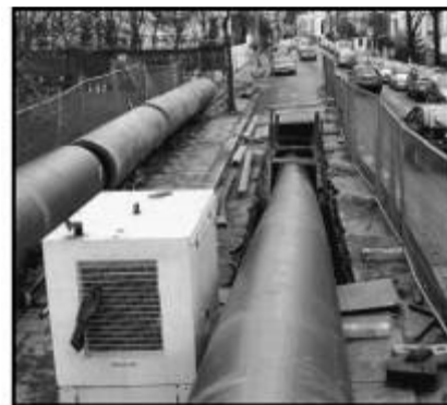
Rysunek 1. Renowacja starego wodociągu żeliwnego rurą PE o dużej średnicy.
