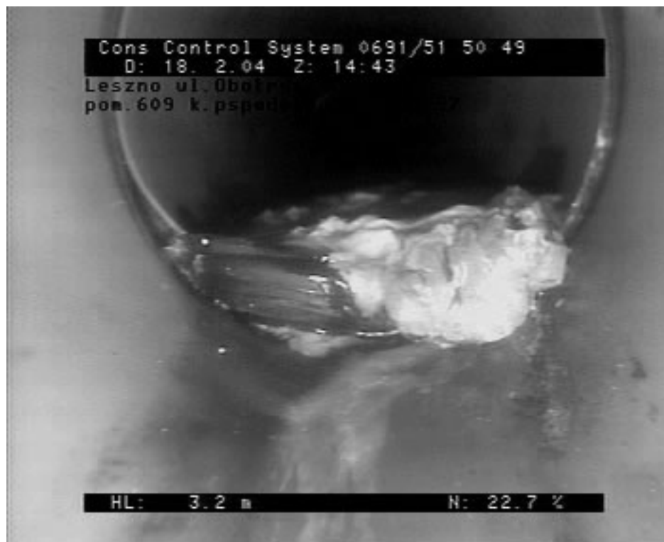
Rys. 3 Zdjęcie wystającej uszczelki ( Cons Control System)
