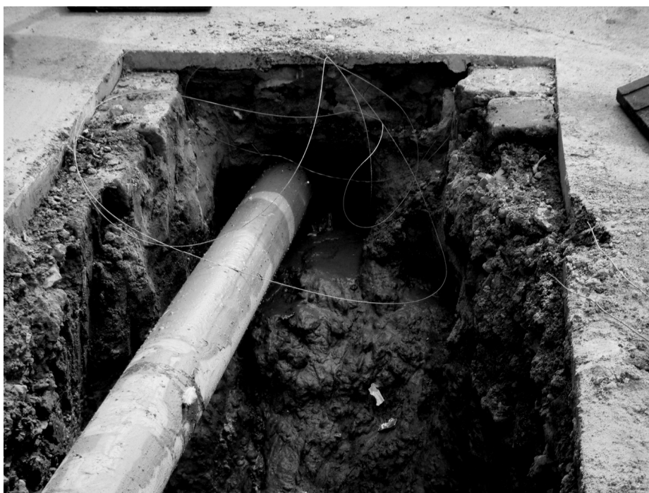
Realizacja wodociągu 225 mm w ulicy Powstańców w Katowicach metodą przewiertu sterowanego.
