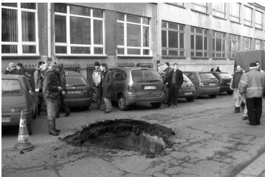
10 grudnia 2008, Katowice ulica Graniczna zapadlisko powstałe w wyniku podmywania asfaltu przez eksfiltrację ścieków z kanału ogólnospławnego.
