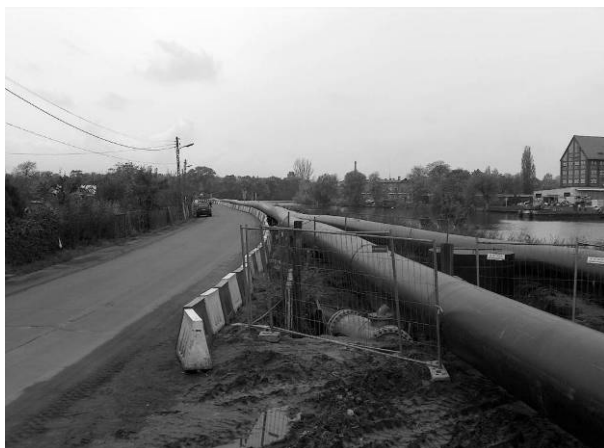
Rurociągi w trakcie zgrzewania
