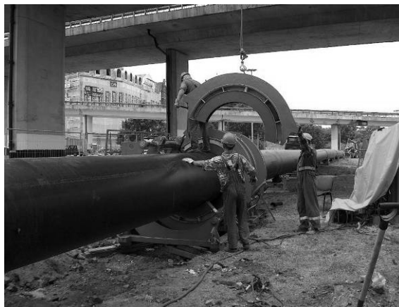
Zgrzewanie rur PE 1033
