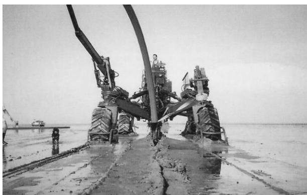
Rysunek 14. Układanie wodociągu w gruncie mocno nawodnionym.
