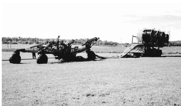
Rysunek 2. Układanie kilku kabli jednocześnie.
