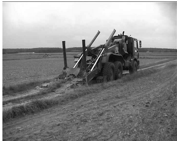
Rysunek 25. Płyta oporowa zabita w ziemię – ciągnięcie pługoukładacza.
