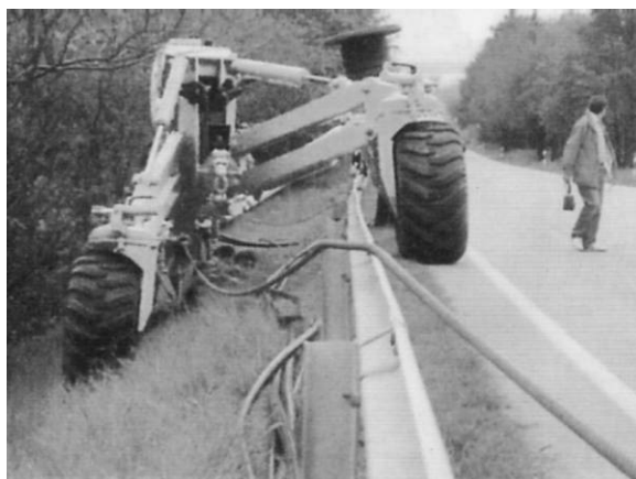
Rysunek 10. Układanie kabli wzdłuż drogowej bariery ochronnej
