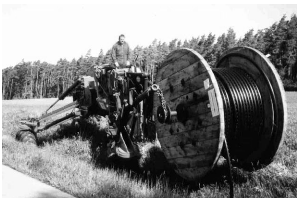
Rysunek 3. Bęben kablowy zamontowany na pługoukładaczu.
