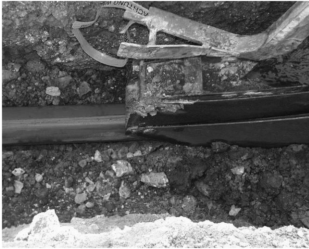
Rysunek 5. Wyjście rury i taśmy ostrzegawczej z prowadnicy pługoukładacza; widoczna na zdjęciu rura PE może być układana bez obsypki piaskowej – zdjęcie z archiwum firmy Wavin.
