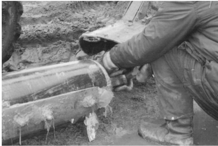
Rysunek 8. Mocowanie rury do pługu kreciego.
