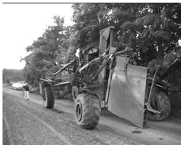
Rysunek 27. Prowadnica rur zamocowana do słupicy i lemiesza; podczas płuzenia w znacznej części są one zagłębione w gruncie.
