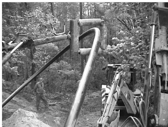
Rysunek 21. Przeciąganie rury PE przez tor w prowadnicy.
