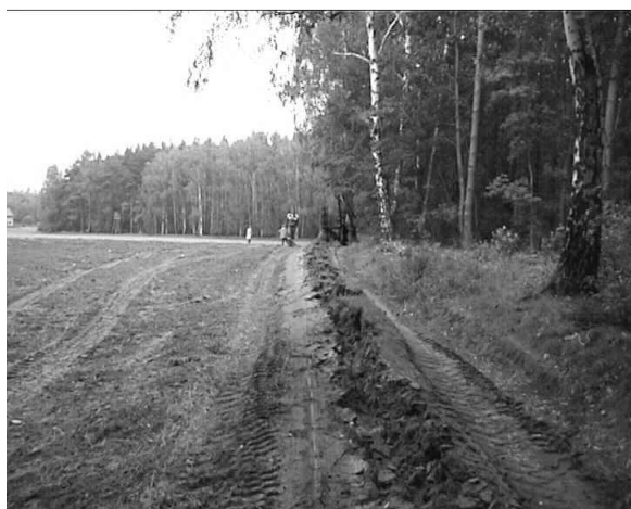
Rysunek 30. Nawierzchni drogi po przejściu pługoukładacza.
