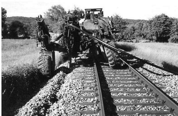
Rysunek 16. Układanie kabli wzdłuż torów kolejowych.
