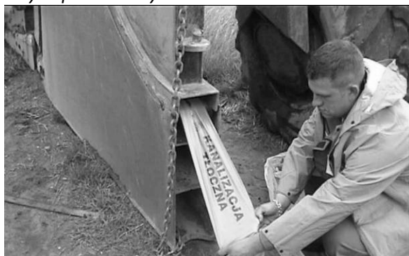
Rysunek 20. Stalowy łańcuch (wykorzystywany do przeciągnięcia rury PE) oraz taśma ostrzegawcza przeciągnięte przez odpowiednie tory w prowadnicy rur.
