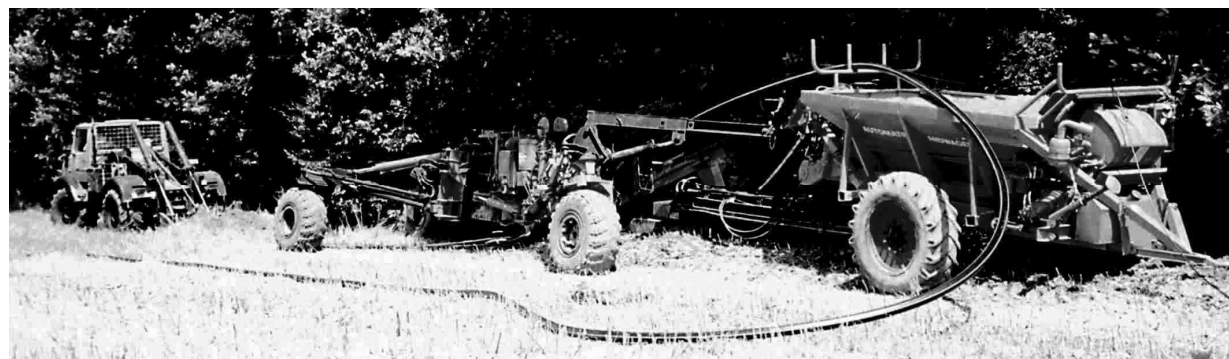
Rysunek 4. Układanie rury PE w obsypce piaskowej (od lewej: wciągarka, pługoukładacz, wózek z automatycznym podajnikiem piasku).
