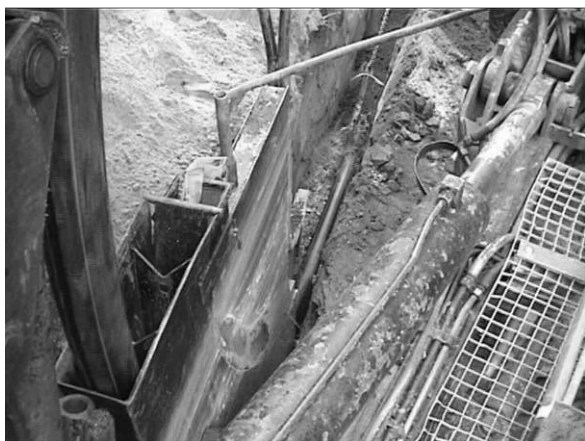
Rysunek 22. Przeciąganie rury PE przez tor w prowadnicy.
