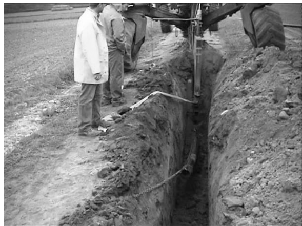
Rysunek 23. Początek płuzenia. Koniec rury PE trzymany jest na łańcuchu zaczepionym do koparki. Taśma ostrzegawcza nie potrzebuje tak dużej siły kotwiącej.
