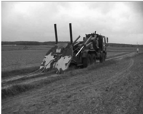
Rysunek 24. Wciągarka linowa na ciągniku kołowym – przejazd na nowe stanowisko robocze; ciągnik ten holuje przyczepę z pługoukładaczem podczas jazdy na plac budowy.
