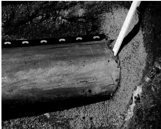
Rysunek 11. Rura i kabel telefoniczny ułożone wspólnie w obsypce piaskowej.
