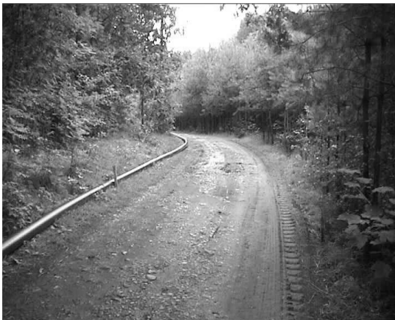
Rysunek 32. Pługoukładaczem można układać rurociągi w łukach dróg.
