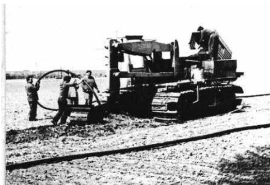
Rysunek 33. W Polsce metodą płuzenia układano gazociągi z rur PE już w drugiej połowie lat 70. Zdjęcia z archiwum p. W. Jeżowskiego.
