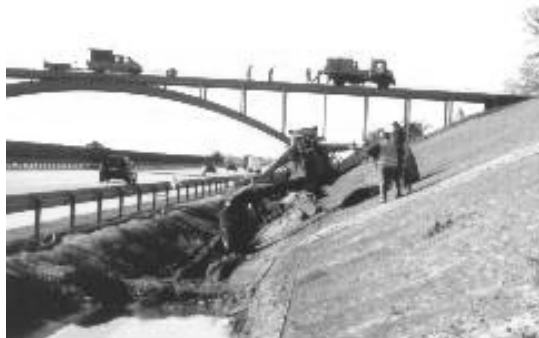
Rysunek 17. Układanie rur i kabli wzdłuż autostrady
