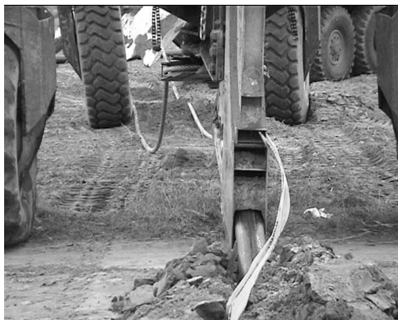
Rysunek 28. Wyciąganie rurociągu na wierzch jest alternatywą dla kończenia płuzenia w wykopie końcowym; oszczędza czas.
