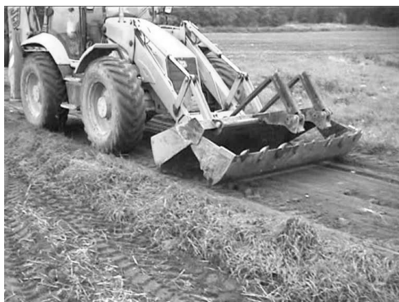
Rysunek 29. Wyrównywanie nawierzchni drogi gruntowej, w której układany był rurociąg.
