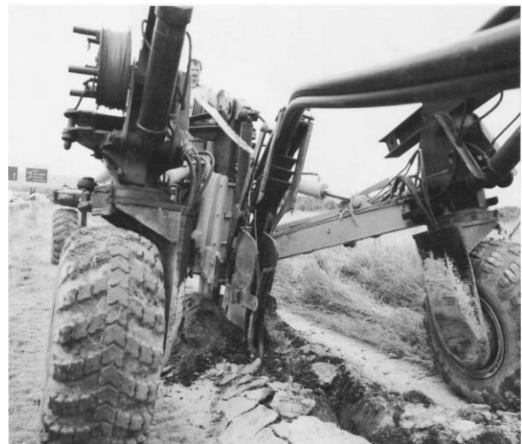
Rysunek 6. Układanie rur do kanalizacji j kablowej – zdjęcie z katalogu Rehau
