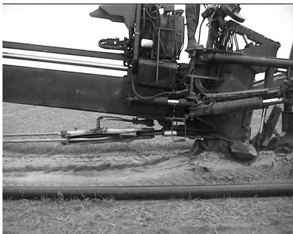
Rysunek 26. Wypiętrzenie gruntu podczas płuzenia.
