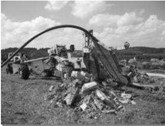
Rys.3: Płużenie rur
