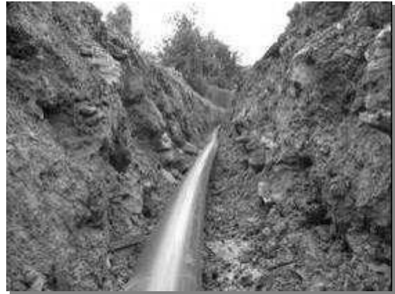
Rys.4: Budowa bez zastosowania piasku
