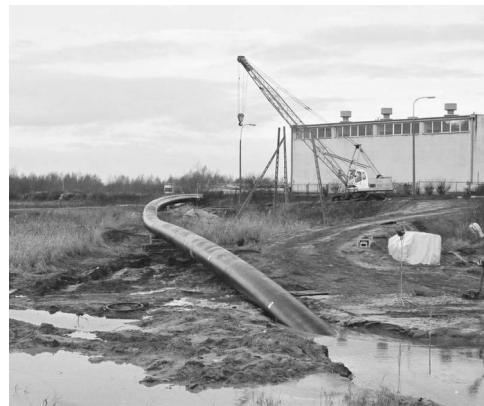
Rys.21. Przykłady zastosowania rur z tworzyw sztucznych w technologii HDD – przewiert horyzontalny:
