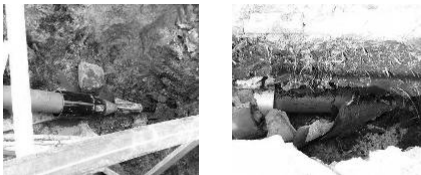
Rys.22. Przykłady zastosowania rur PE z warstwami ochronnymi w pipe bursting.
