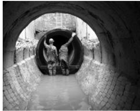
Rys.20. Przykłady zastosowania technologii bezwykopowej do renowacji krótkimi odcinkami rur z tworzyw sztucznych:
