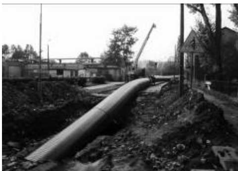
Rys.19. Przykłady zastosowania technologii bezwykopowej do renowacji długimi odcinkami:
