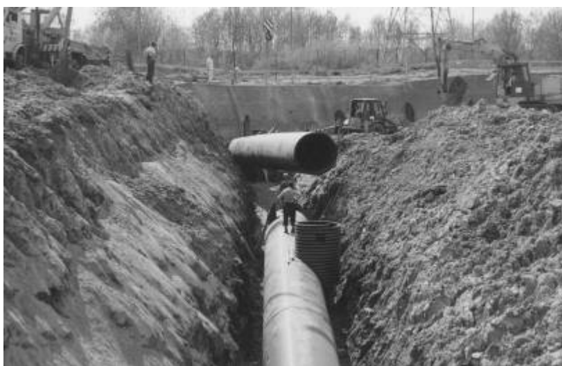
Rys.10. Przykład kolektora kanalizacyjnego wykonanego systemowo z rur i studni z polietylenu. Średnica kolektora 1500mm.
