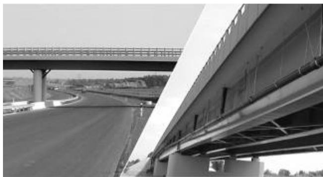
Rys.16. Przykład odwodnienia obiektów mostowych za pomocą systemu z PE.
