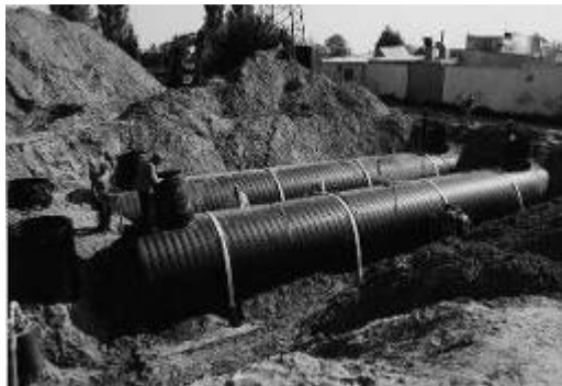
Rys.18. Przykłady zbiorników wykonanych z rur z tworzyw sztucznych:
