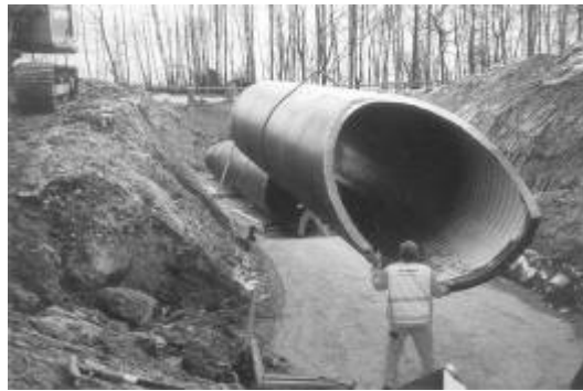
Rys.24. Montaż przepustu drogowego z rury strukturalnej.
