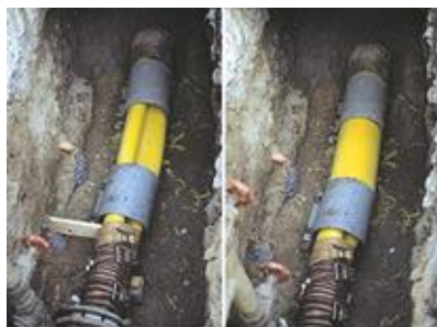
Rys. 23. Przykłady zastosowania rur PE w technologii ciasnopasowanej
