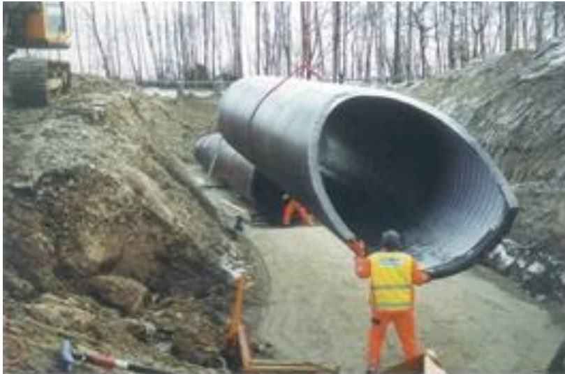
Rys. 24. Montaż przepustu drogowego z rury strukturalnej
