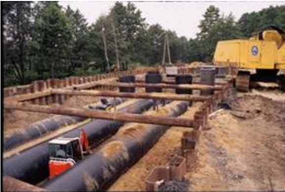
Rys. 16. Przykłady zbiorników wykonanych z rur z tworzyw sztucznych: A. zbiorniki pojedyncze, B. układ połączonych zbiorników
