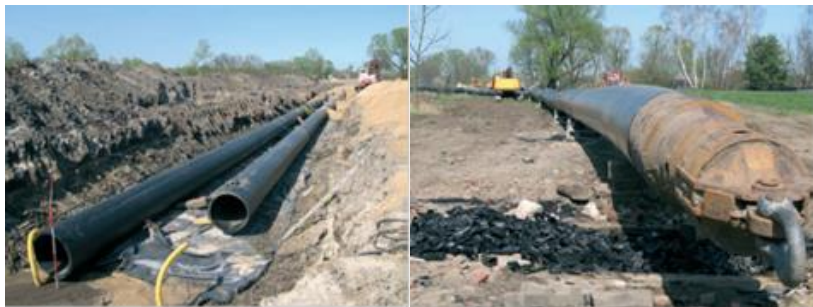
Rys. 28. Rurociągi tłoczne do oczyszczalni Pomorzany – układanie rur w wykopie otwartym
