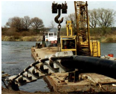
Rys. 25. Przykłady zastosowania swobodnego zatapiania rur PE w rzece i otwartym morzu:
