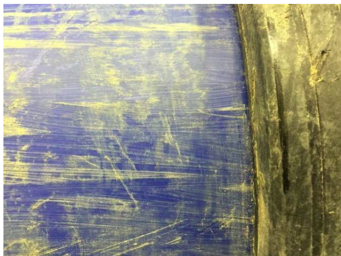
Fot.7 Wadliwe połączenie elektrooporowe w wyniku braku poprawnego przygotowania powierzchni do zgrzewania
