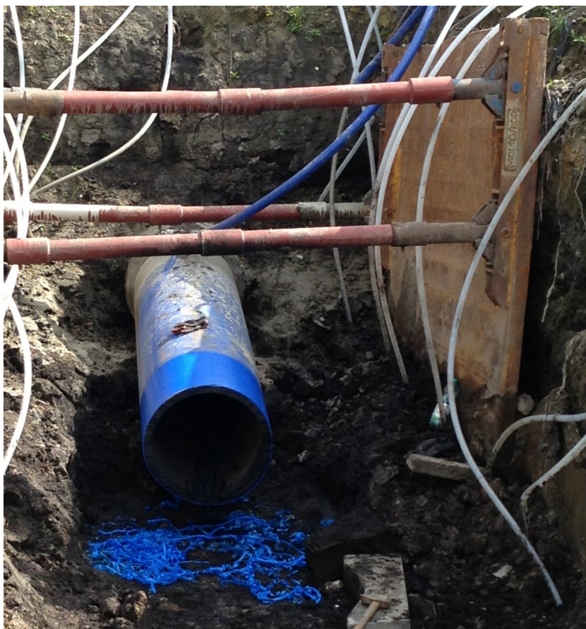
Fot.10 Poprawnie przygotowana powierzchnia rury do zgrzewania
