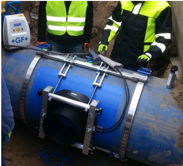
Fot.12 Poprawnie zamontowane odejście siodłowe
