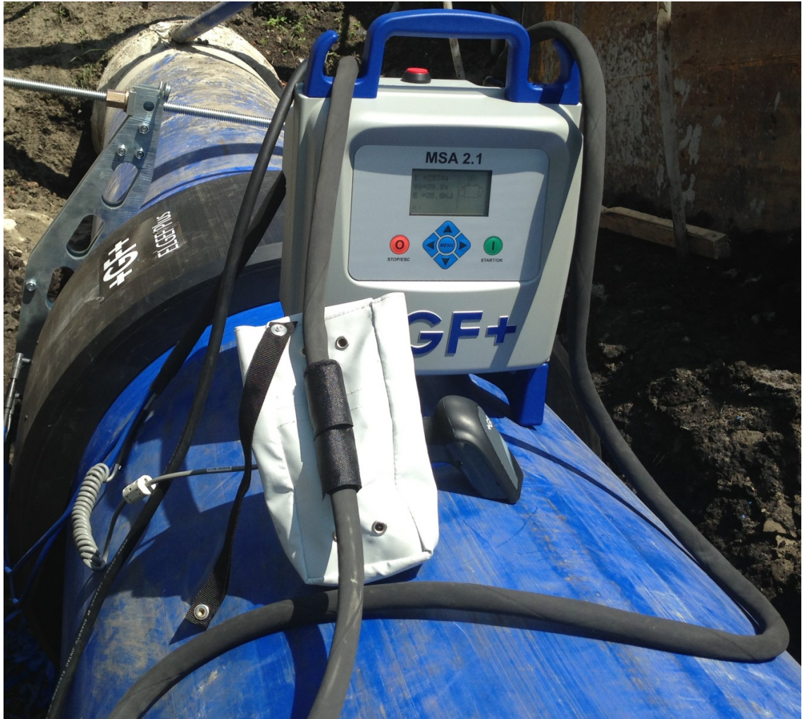
Fot.3 Zgrzewarka elektrooporowa – zgrzewanie mufy d710
