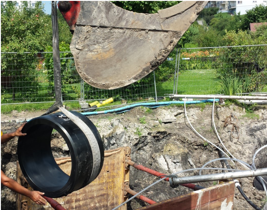
Fot.2 Opuszczanie mufy elektrooporowej do wykopu.
